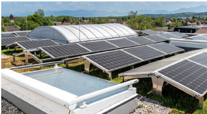
© Theinert-Maier-Architekten, Salus Gebäude
