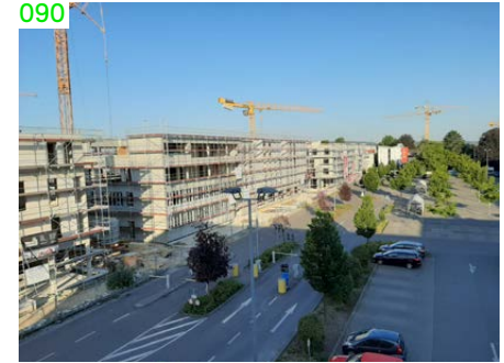
M Kirchheim u. T., Steingauquartier (→ 17): Baufortschritt (August 2020) – es entstehen ca. 200 Mietwohnungen mit preisreduzierten Mieten
