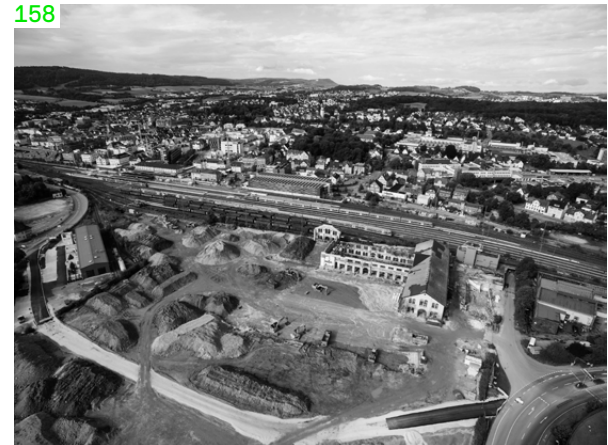
Das freigeräumte Areal mit Bestandsgebäuden
