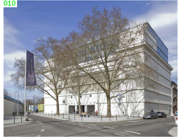
B Mannheim, MARCHIVUM und Quartiersentwicklung Neckarstadt-West (→ 23): neu gestalteter Vorbereich als Eingang zum neuen Lernort
