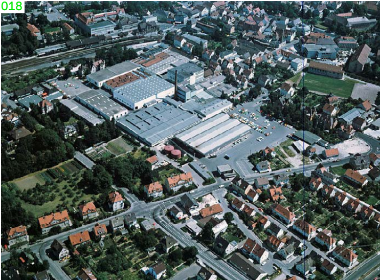
C Kirchheim u. T., Steingauquartier (→ 17): Ausgangssituation – Maschinenfabrik (1975)
