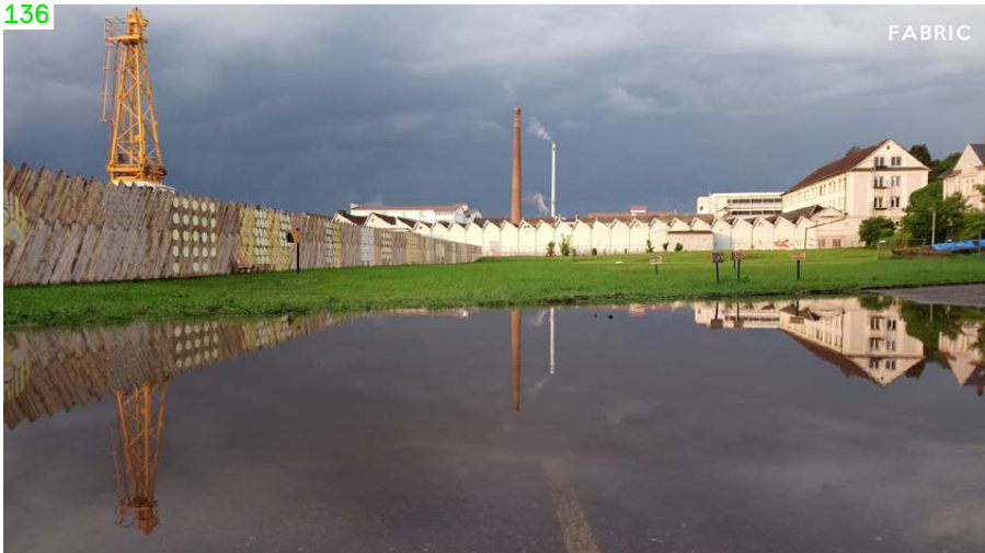
S Lörrach, FABRIC – Planung als Plattform (→ 22): Das Planungsgelände in Brombach – gute Ideen gesucht
