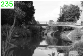
›Stuttgarter Holzbrücke‹ – ein neuer Baustein im Radwegenetz
